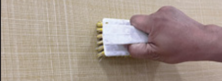
Motif Kedua Dalam keadaan basah, tarik cat yang telah diaplikasi secara searah (vertikal) menggunakan kuas/sikat
