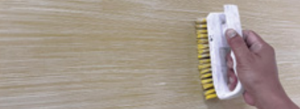
Motif Pertama Dalam keadaan basah, tarik cat yang telah diaplikasi secara searah (horizontal) menggunakan kuas/sikat
