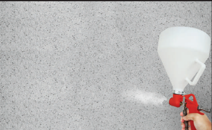
Cat Aksesoris (*Optional) Leganza Stonewall (Decorshield yang dicampur dengan Leganza Filler, 1:1) 1x lapis (by spray)
