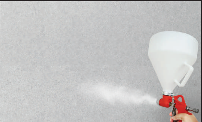
Cat Tekstur Leganza Stonewall (Decorshield yang dicampur dengan Leganza Filler, 1:1) 1x lapis (by spray)
