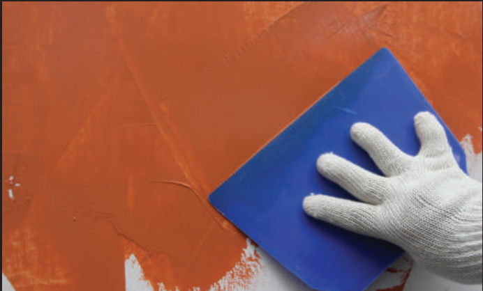
Cat Basecoat Aplikasikan 1-3x lapis Leganza Stucco ke seluruh bidang menggunakan kape plastik hingga rata dan menutup warna cat dasar.
