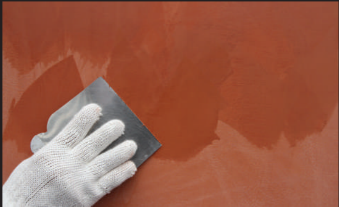
Membuat Motif Marmer Aplikasikan 2 - 3x lapis Leganza Stucco secara acak menggunakan kape stainless steel untuk menciptakan motif marmer.
