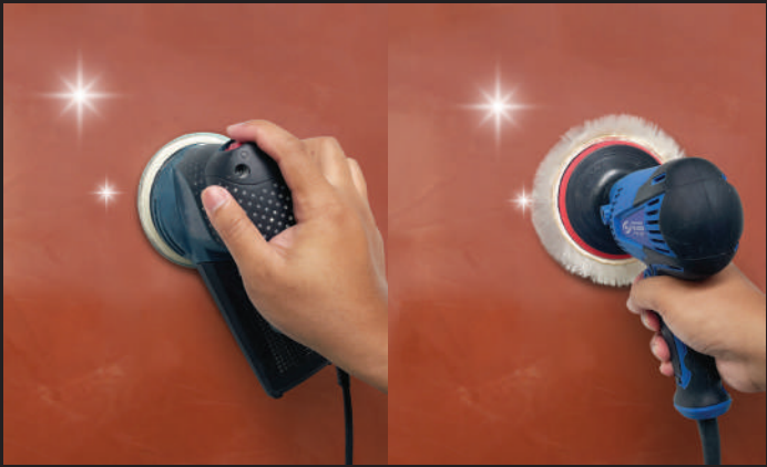
Membuat Efek Lebih Kilap Segera gosok menggunakan amplas orbital dengan kertas amplas no. 1000. Jika ingin lebih kilap, lanjutkan penggosokan menggunakan alat buffing tanpa wax atau rubbing compound.
