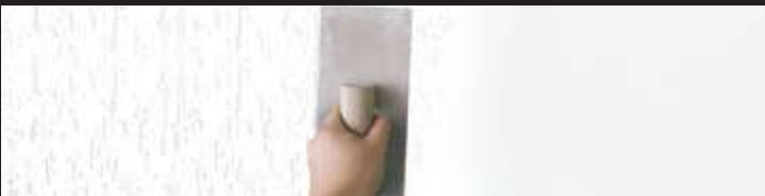
Membentuk Motif Gosok menggunakan roskam/trowel plastik secara horizontal dan/ atau vertikal
